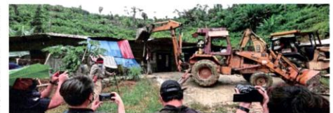
Ops Lagong merobohkan struktur binaan haram di Hutan Simpan Bukit Lagong Gombak, semalam. (Foto BERNAMA)
